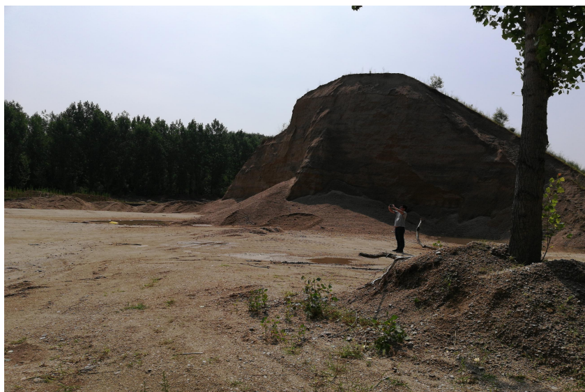
照片 2-4 矿渣不稳定斜坡
