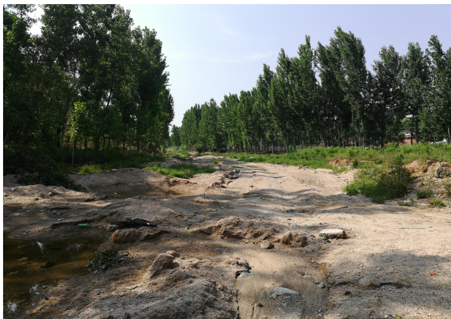
照片 2-9 废渣淤积河道
